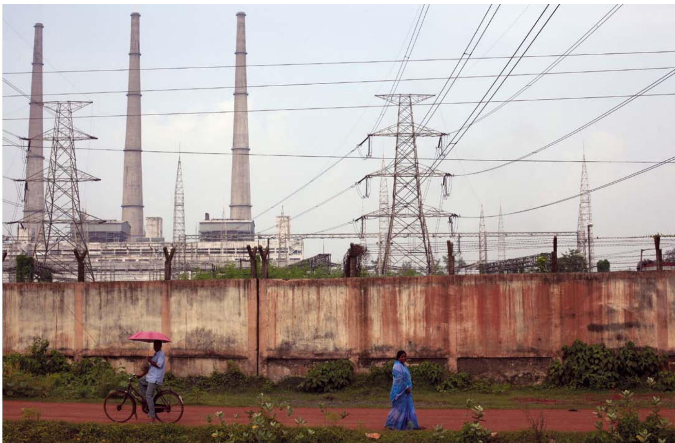
Pohled na tepelnou elektrárnu Kolaghat ve Východním Medinpuru, Západní Bengálsko, Indie. Autor fotografie: Christian Aid / Elizabeth Dalziel
