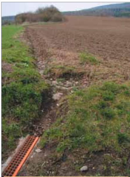
Příklad zcela nevhodného opatření, které neřeší příčinu, ale následky vodní eroze půdy. Zároveň ohrožuje obec v případě přívalové srážky záplavou vody a bahna. (Řídeč u Šternberka, duben 2013)
