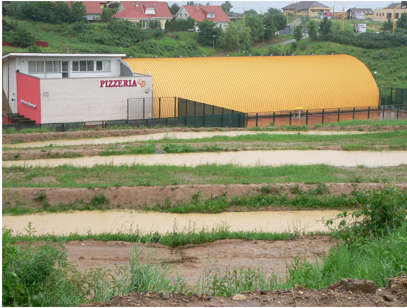
Obr. 36 Sídliisko KVP v Košiciach – ochrana objektov pod svahom pomocou zemných hrádzok vedených po vrstevnici
