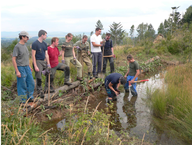
Obr. 35 Vodný les vo Vysokých Tatrách – budovanie vodozadržných opatrení na území zničenom prírodnou katastrofou Príklad obnovy vegetácie a hydrologickej stabilizácie územia prostredníctvom zadržiavania vody v krajine.
