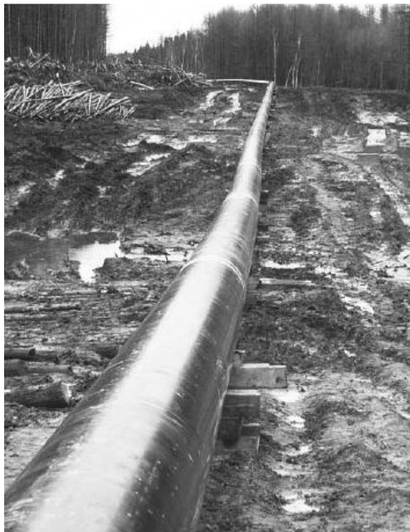
(obr.) Průsek lesem při ukládání potrubí Shellu Sachalin II. (Sakhalin Environment Watch)
