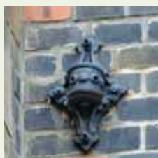
Růžice trolejbusového vedení
