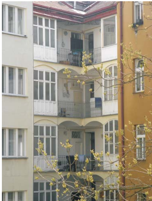
Rekonstrukce v Trojické 11 se pavlačí vůbec nedotkla. foto OH
