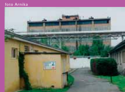
Budova bývalé výroby pesticidů ve Spolaně je vysoce kontaminovaná dioxiny a dalšími toxickými látkami. Její demolice a vyčištění bude stát 2,7 miliardy korun.
