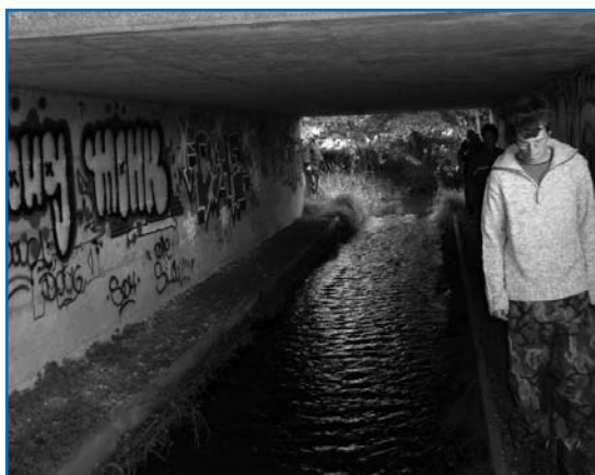
Silniční podchod pro živočichy, především pro vydry, které v noci cestují podél toku a hledají nová teritoria.
