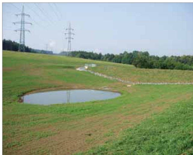
Technické řešení – polder u Kateřinic, který je prostou hrází zachycující přívalové srážky – je obohaceno o vodní plochu, dno poldru bylo zatravněno. Zatravnění přítoku bylo zrušeno a upraveno do podoby otevřeného koryta, byly vysazeny dřeviny, bohužel již mimo záběr.
