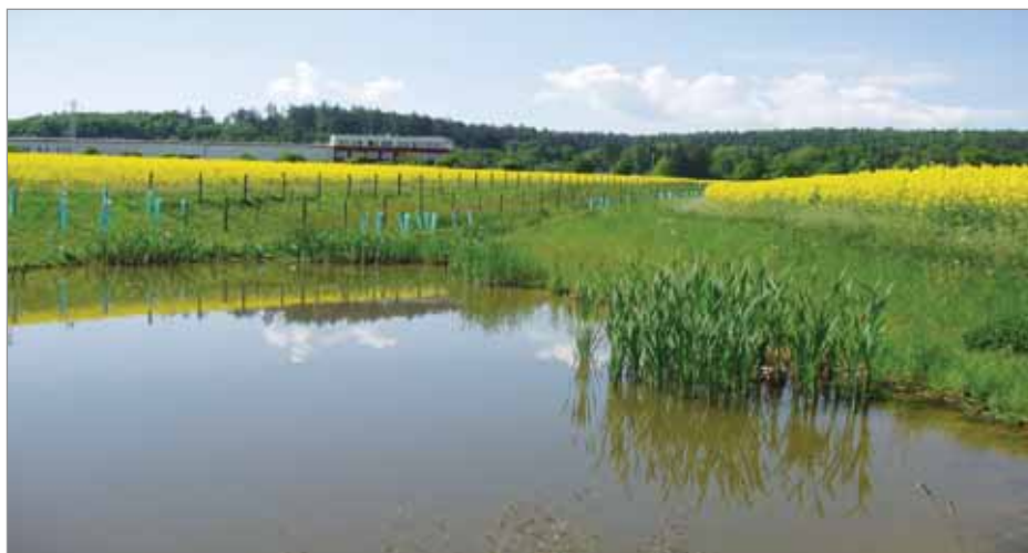
Po realizaci. V zatrubněném pásu, který byl mírně zahlouben do terénu jako nová potoční niva, se vine potůček, byly vysazeny stromy a keře a vytvořeny dvě tůňe a nad obcí rozlivná plocha jako mokřad s vrbami. Odvodnění polí kolem bylo zachováno a ústí do potoka.
