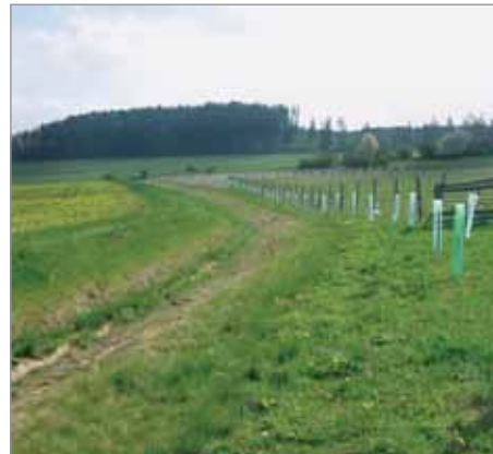
Lichnov – průleh se založenou výsadbou dřevin v pásu nad ním – voda stékající ze svahu zde zasakuje, zpomaluje se a průlehem je odváděna do poldru
