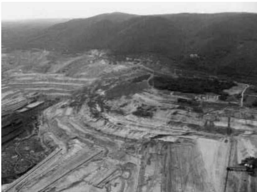
Čelní pohled na uhelný velkolom v polovině roku 2005, kdy se z čela stabilizačního pilíře pod Jezeřím uvolnil mohutný sesuv v kubatuře cca 3 miliony m 3 pánevních sedimentů.
