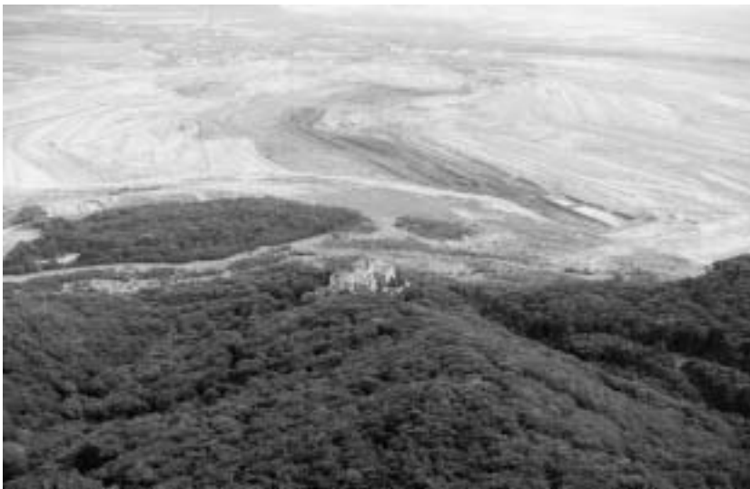
Pohled z Krušných hor na stabilizační pilíř pod zámek Jezeří se zachovaným arboretem. Uhelný velkolom v pozadí.
