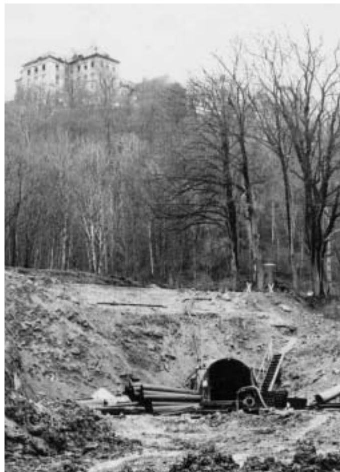
Průzkumná štola pod zámekem Jezeří - hlavní objekt podrobného inženýrsko-geologického průzkumu.
