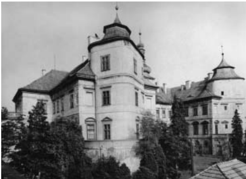
Pravá část zámku spočívá na pevné žulorule, levá část na tektonické poruchové zóně, ve které je hornina rozložená na písčitojilovitou zeminu.
