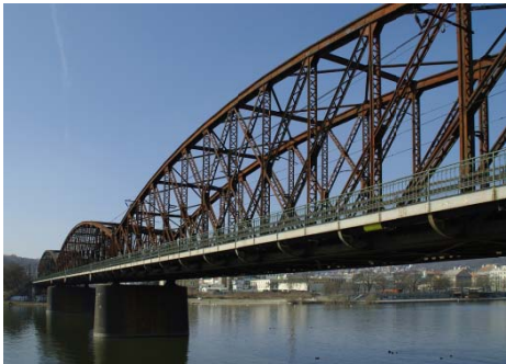
železniční most 2010, foto Marek Novotný
